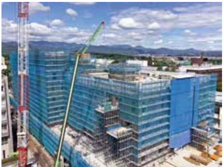
躯体工事全景を南東より見る
