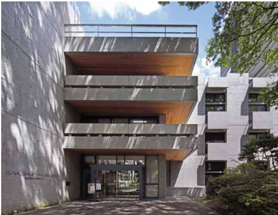
改修後：軒天に杉板を使用
