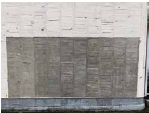
上／改修前* 下／既存塗装を剥離する調査の様子*
