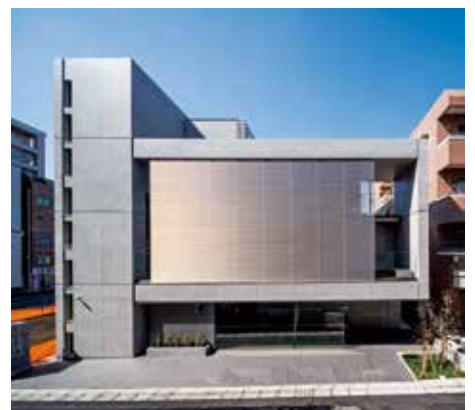
前面道路からの外観全景
