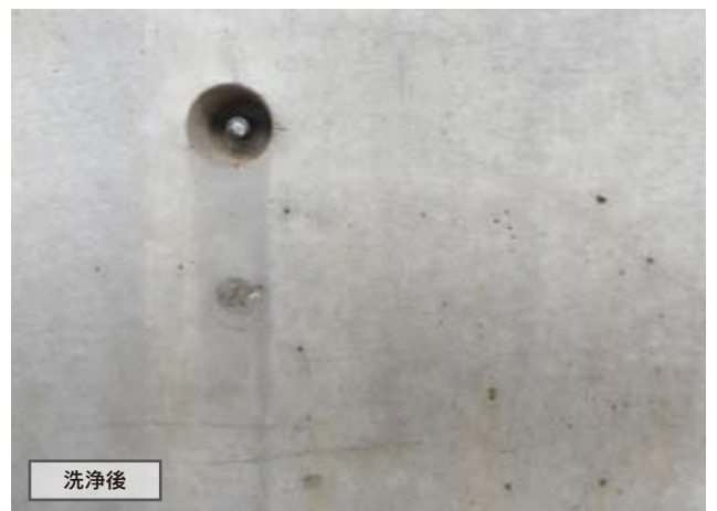
(例) PG クリーナーによる「サビ・木アク」の洗浄除去
